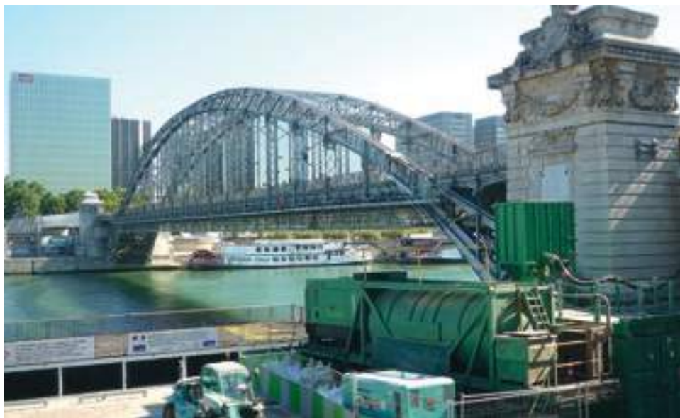
Pont ferroviaire en milieu urbain, catégorie C3
