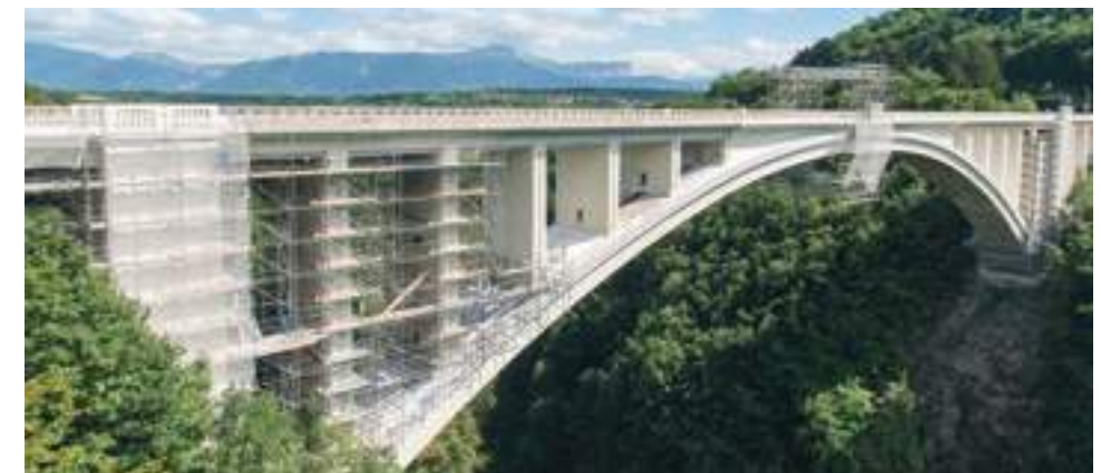
Chantier de mise en peinture d'un pont en béton.
